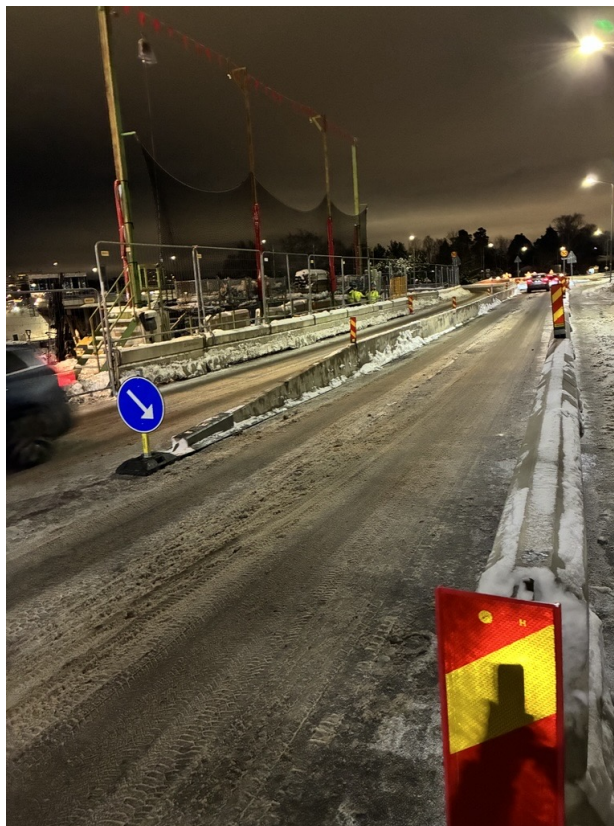
Figur 2: Fotografi över berörd sträcka på Stockholmsvägen intill kvarteret Strömmingen
